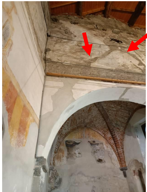
Andamento quadro fessurativo ad arco
