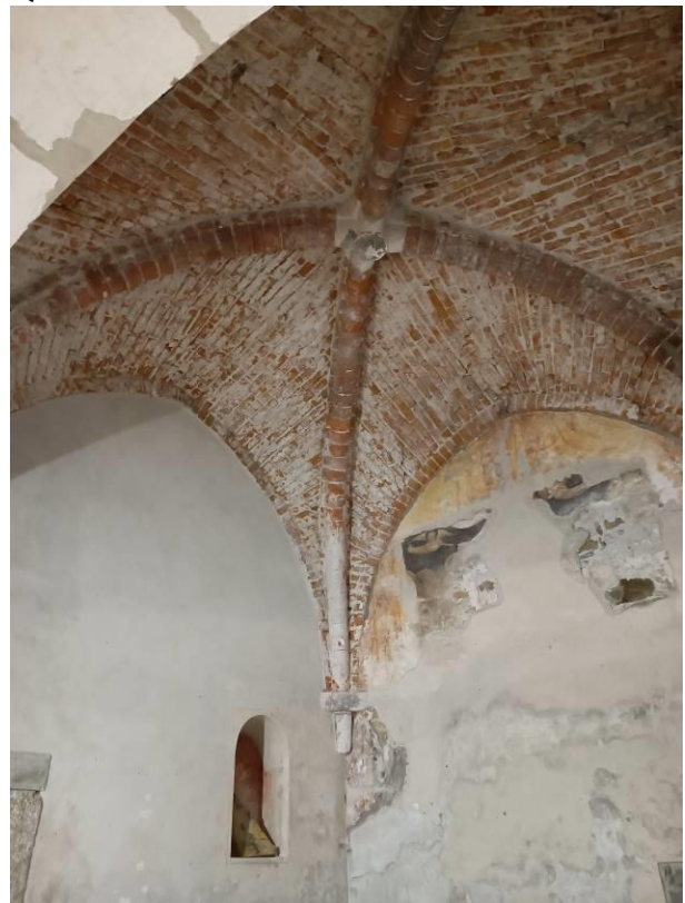
Quadro fessurativo volta del coro
