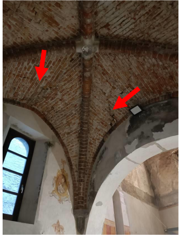
Quadro fessurativo volta del coro
